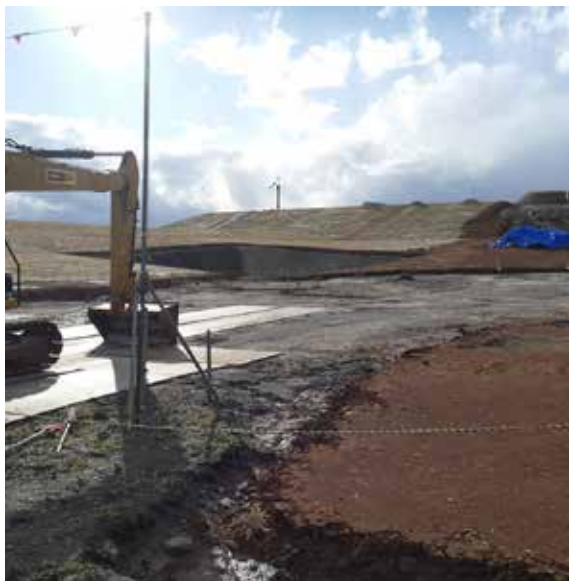
建設中の避難の丘
