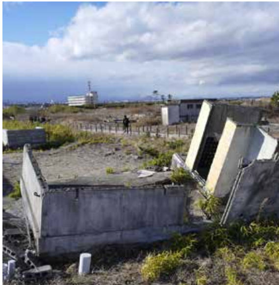
仙台市荒浜地区住宅基礎
