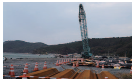
荻の浜 巨大工事クレーン
