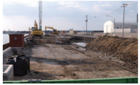
石巻漁港 地盤かさ上げ工事
