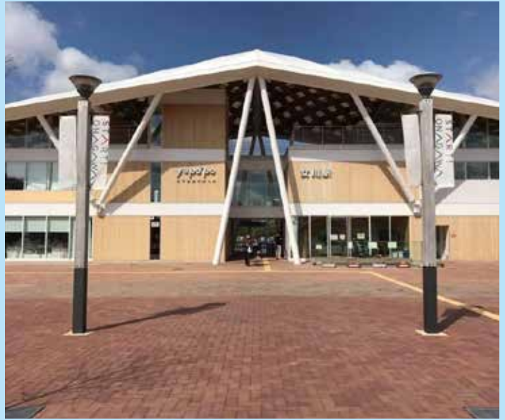
JR線も開通した立派な新駅舎(女川)
