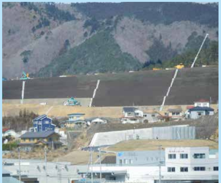
遠くの山では高台住宅地造成中
