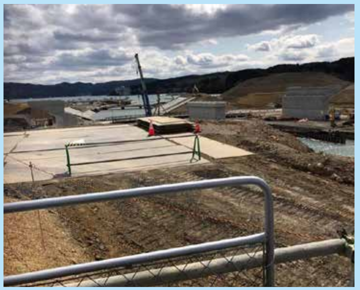
商店街のすぐ隣は土地造成工事中(南三陸町)
