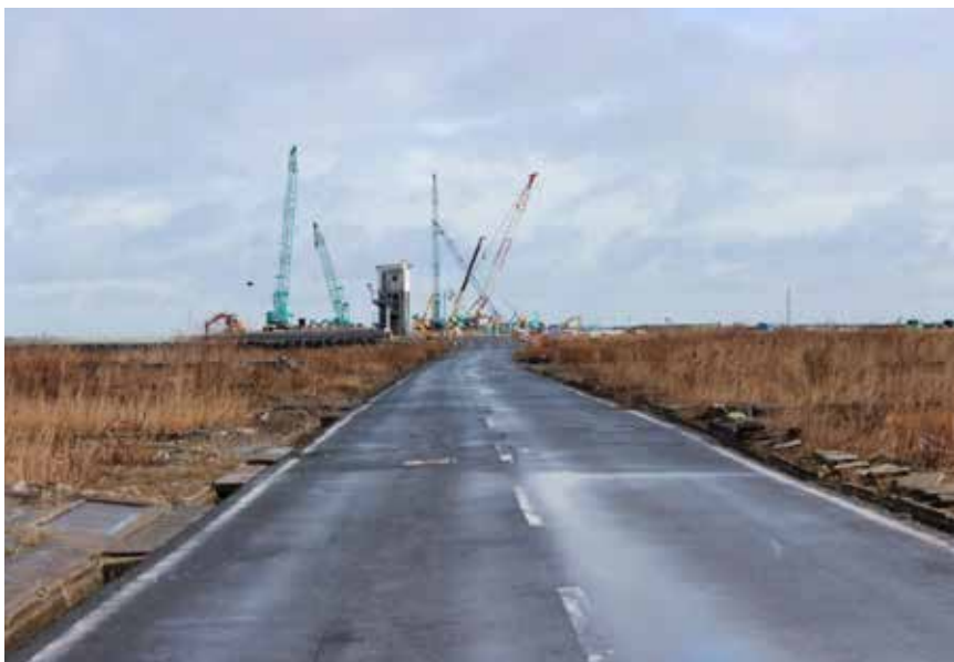
工事用クレーンが林立する閑上港遠景
