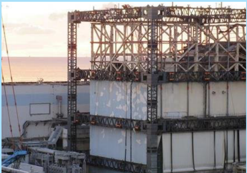
福島第一原発一号機建屋カバー解体後
