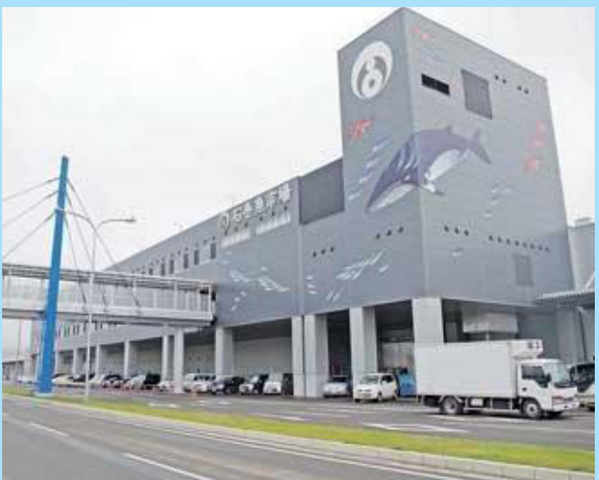
【写真】1日から全面供用を開始した石巻魚市場の新施設
