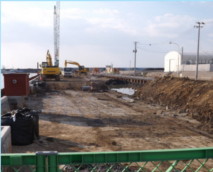
工事開始 2012年10月
