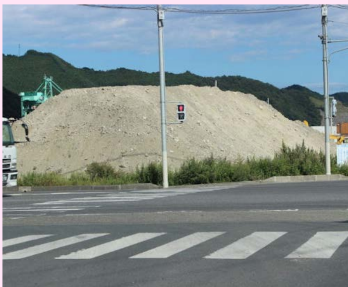
土盛工事 釜石 いつになったら住めるか
