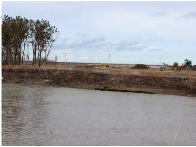
復旧した仙台空港隣接の未復旧の地域
