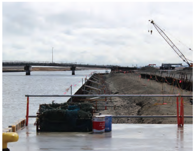
着手したばかりの護岸工事
