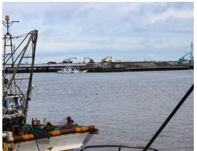
復興工事中の閉上港
