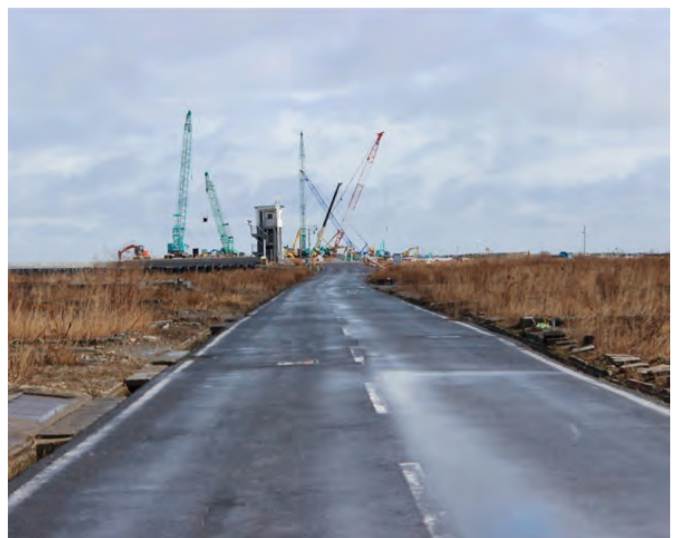
工専用クレーンが林立する閉上港遠景
