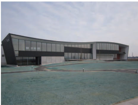
木の屋石巻水産新工場
